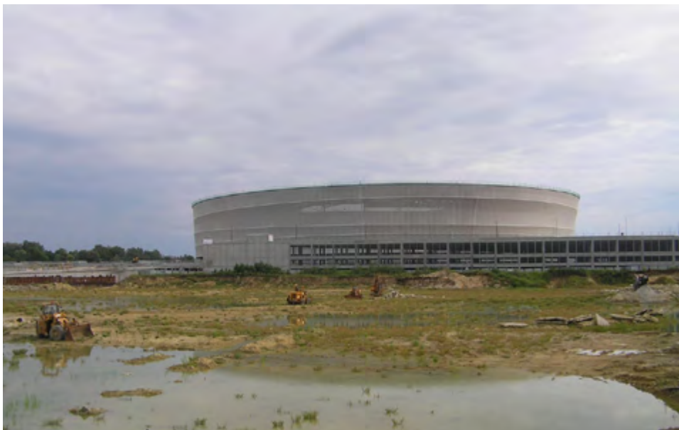
Wrocław, budowa Stadionu - Maślice
